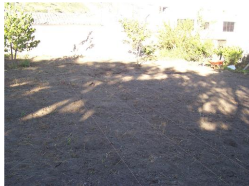
6. Limpieza del lote
