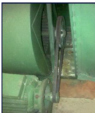
Figura 37: Acople de motor a el Ventilador
