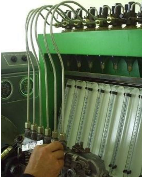
Figura 115. Instalación de cañerías y sangrada de aire de las cañerías.
