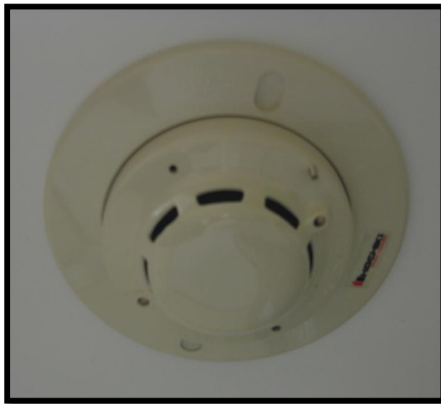
Figura 128 Detector de humo
