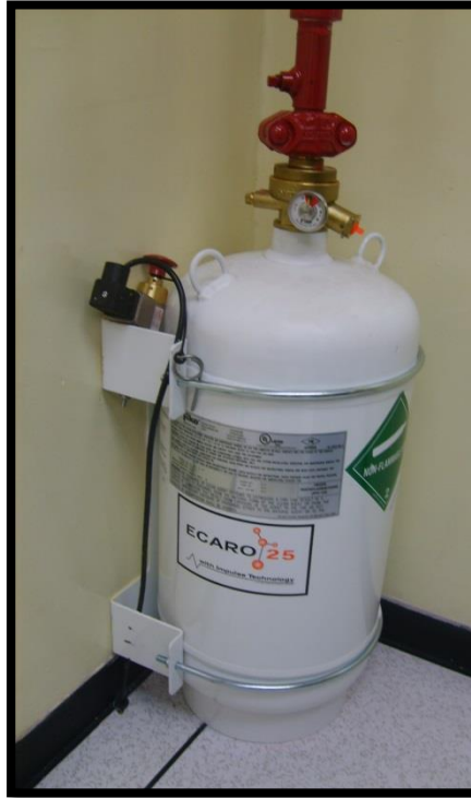
Figura 131 Cilindro agente limpio Fuente: GPI
