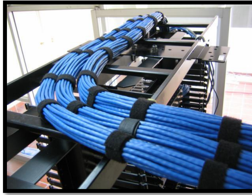
Figura 87 Diseño de Cableado Horizontal Fuente: GPI
