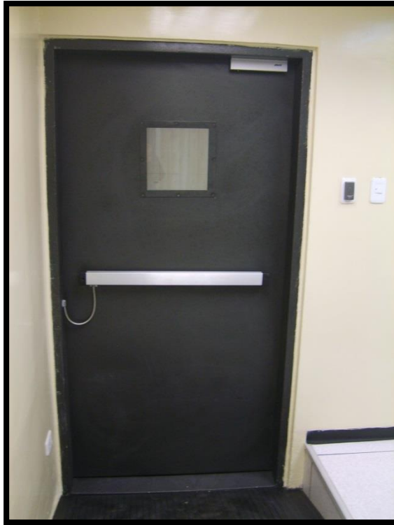
Figura 106 Vista interior puerta de seguridad Data Center GPI Fuente: GPI
