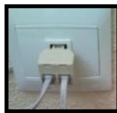
Figura 30 Duplicador RJ11. Fuente: GPI
