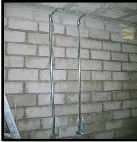
Figura 102 Mampostería de bloque Fuente: GPI
