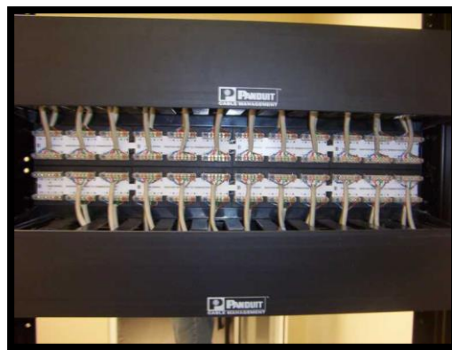
Figura 63 Ponchado de cableado Fuente: http://icomintegration.mex.tl/
