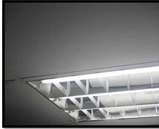
Figura 103 Techo falso Fuente: GPI
