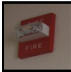
Figura 129 Sirena y luz estroboscópica Fuente: GPI
