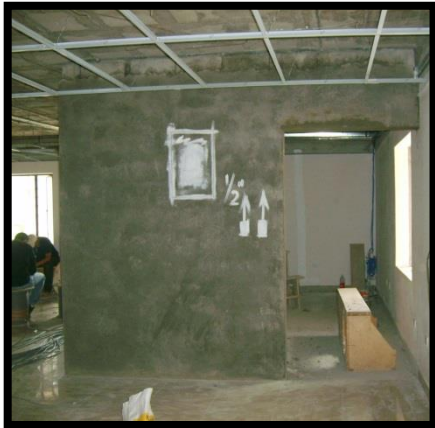
Figura K. 2 Inicios de la construcción Data Center
