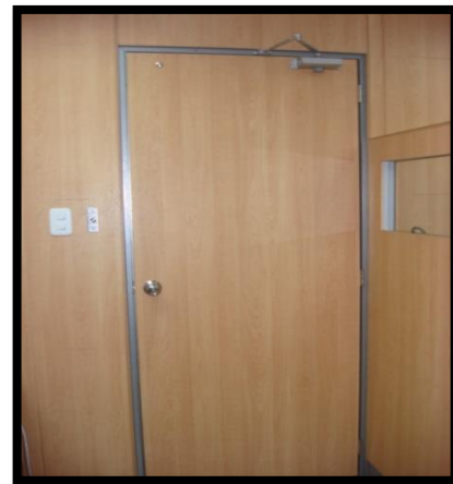
Figura K. 3 Puerta de ingreso externa al Data
