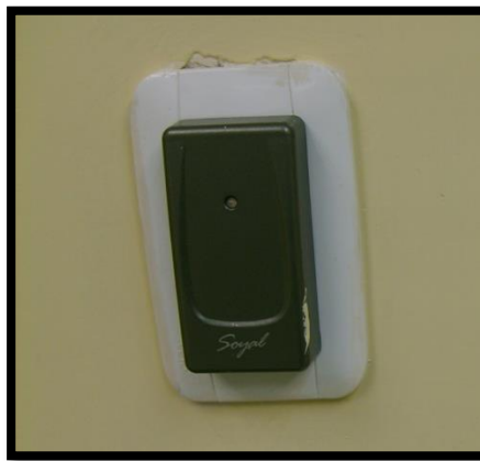
Figura 115 Lector tarjeta rfid Fuente: GPI
