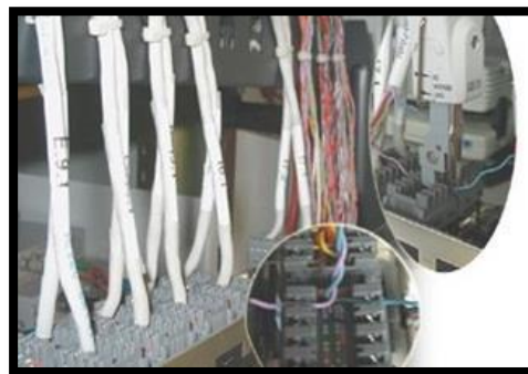
Figura 91 Ponchado de cableado Fuente: GPI
