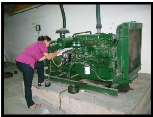
Figura K. 9 Inspección Parte Eléctrica
