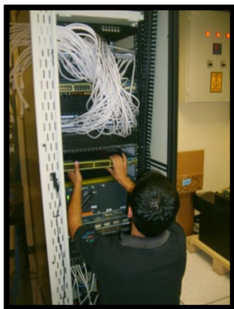
Figura K. 11 Instalación equipos Rack Sinfotecnia.
