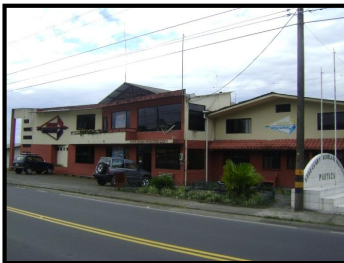
Figura 2. SERVICIO AÉREO REGIONAL (vista hacia la carretera Shell-Puyo)
