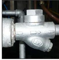
Fig. 24 Trampa termodinámica
