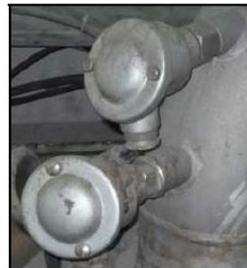
Fig. 33 Termómetros de resistencia
