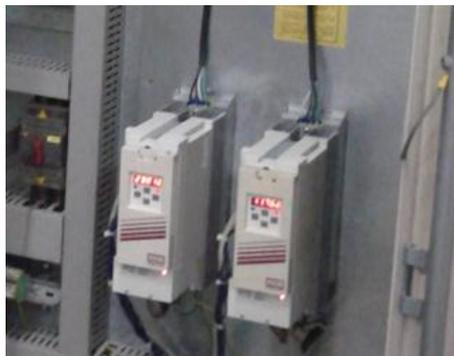
Fig. 32 PLC de control para el motor DC
