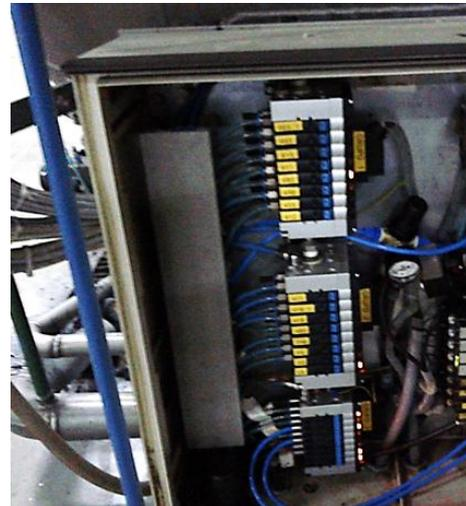
Fig. 19 Bloque neumático
