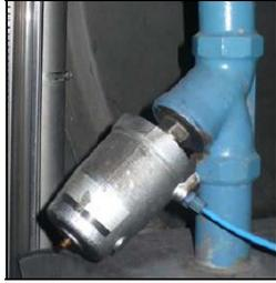
Fig. 16 Válvula de manguito de asiento inclinado
