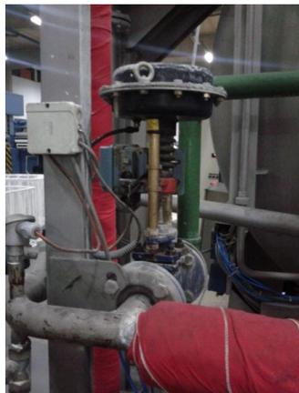
Fig. 22 Válvulas de regulación
