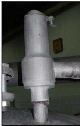
Fig. 26 Válvula de seguridad de sobre presión
