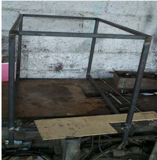
Fig. 136 Construcción de la mesa para la Rueda Fuente: Mecánica “Mundo Tuerca”
