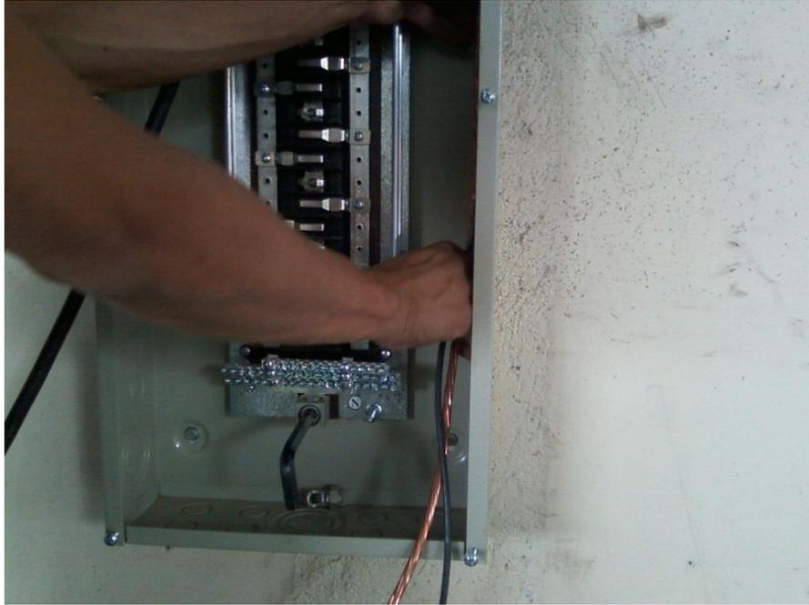
**Foto: N° 5 Instalación de cable para puesta a tierra**
