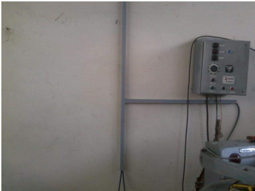
**Foto: N° 10 Instalación de canaletas Monofasicas**
