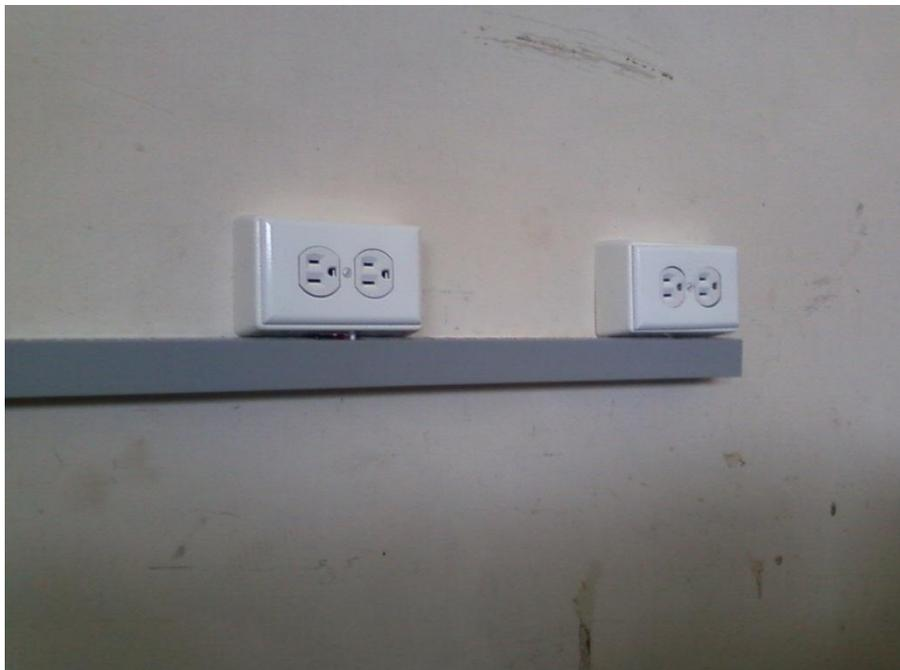
**Foto: N° 12 Tomacorriente Monofasicos Instalados**
