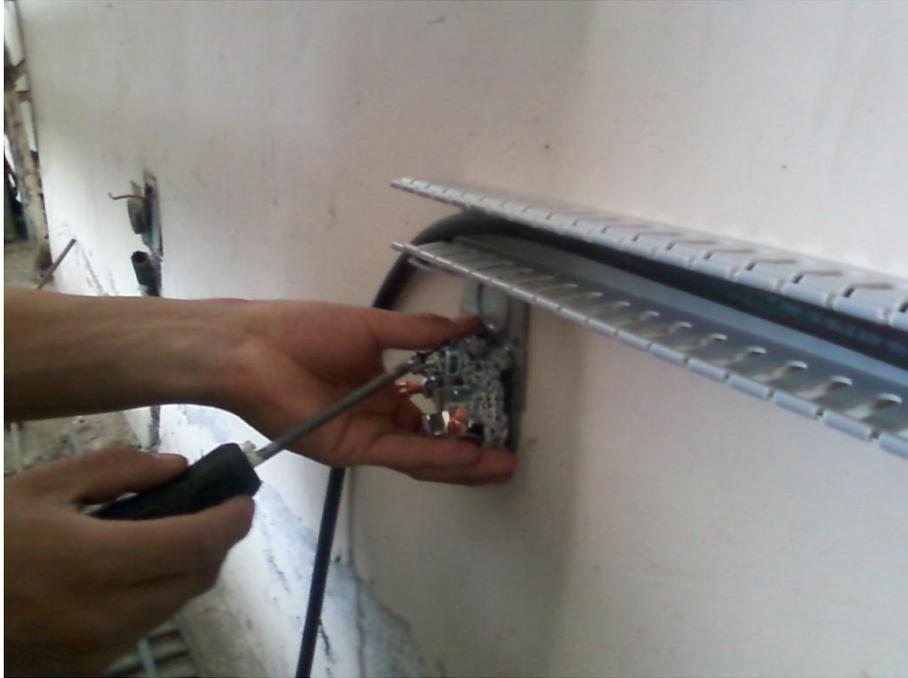
**Foto: N° 9 Instalación de tomacorriente trifásico**
