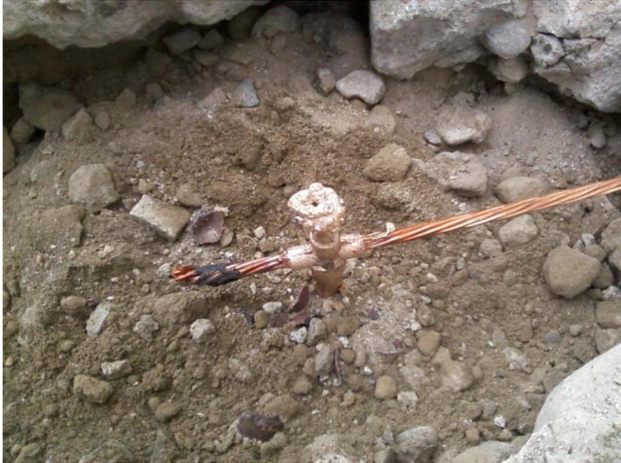
**Foto: N° 7 Aplicación de suelda Capweld**
