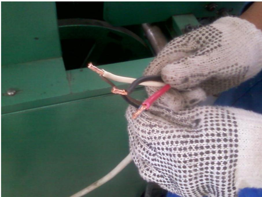
**Foto: N° 8 Empalme de conductores**
