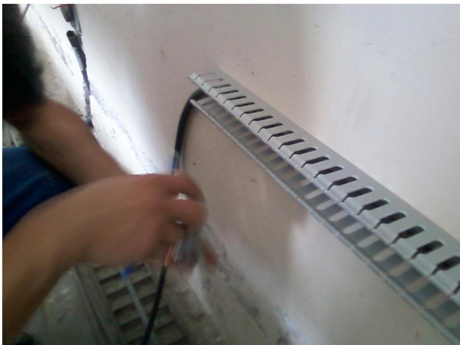
Foto: N° 2 Instalación de canaleta
