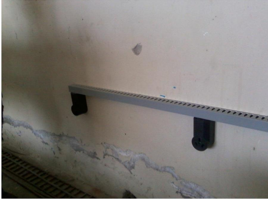
**Foto: N° 11 Tomacorriente Trifasicos instalados**
