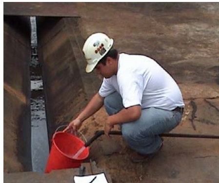
Figura 3.3 Medición volumétrica del caudal
