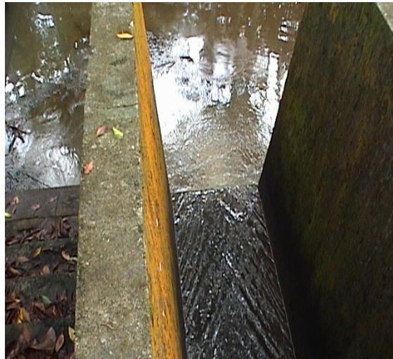
Figura 3.4 Medición de caudal en canal abierto
