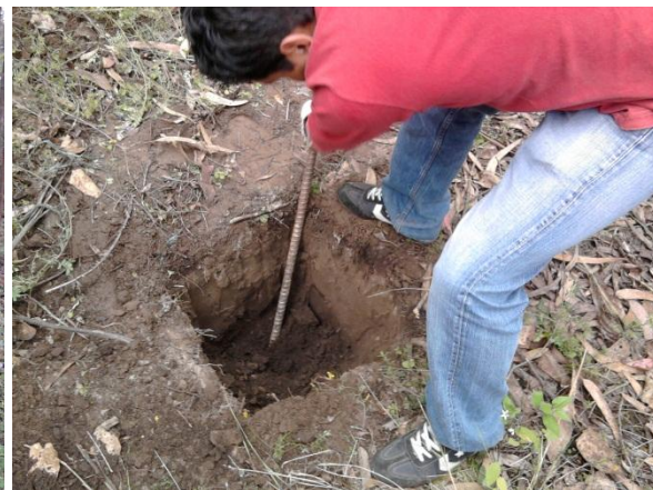
Fotografía 20: Construcción de la calicata
