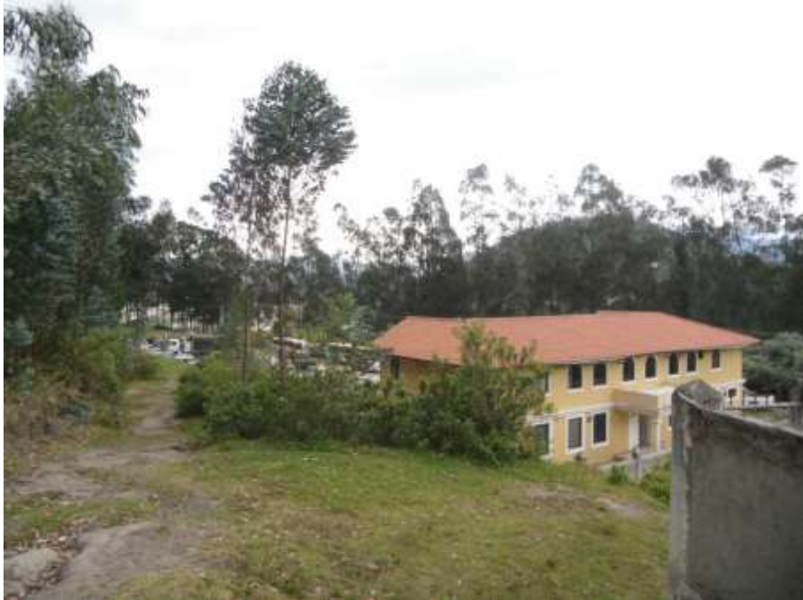
Fotografía 23. Almacén de la Estación de Policía.
