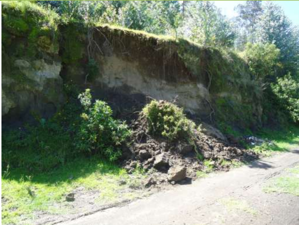
Fotografía 4 Los deslizamientos dentro de la zona provocada por la lluvia
