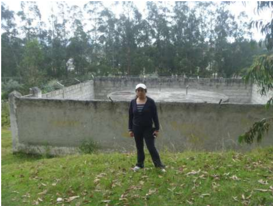
Fotografía 19. Planta de Almacenamiento de Agua, ubicado en la Estación de Policía.
