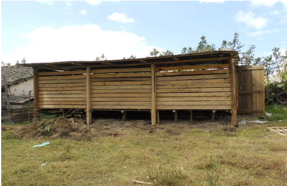
4. Construcción galpón exterior
