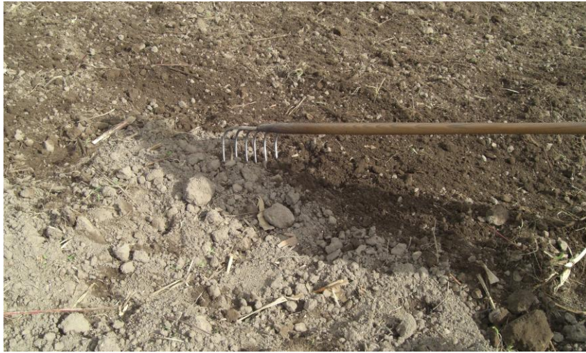
1. Nivelación del terreno
