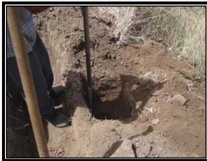
Fotografía 18. Apertura de hoyos bajo la zanja de infiltración. Yahuarcocha, UTN 2006.
