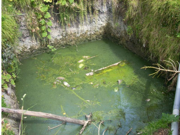
Hoyo utilizado como pozo séptico visible
