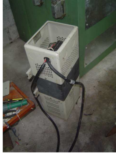
Anexo 7. Banco de condensadores ubicado en el tablero principal.
