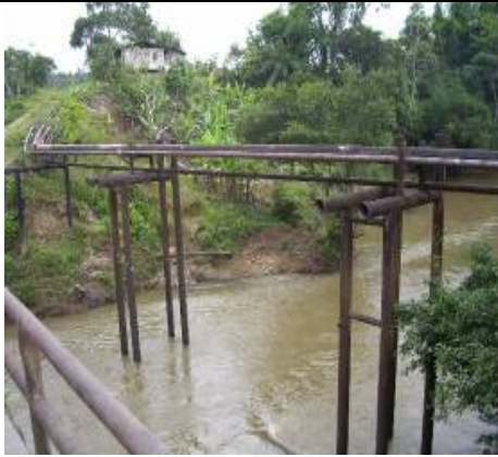
Foto 4.1. Río Tiputini – Calidad de paisaje alterada por presencia del oleoducto, deforestación y erosión
