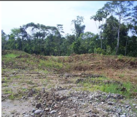
Foto 4.5. Trabajo de remediación de piscinas por PEPDA
