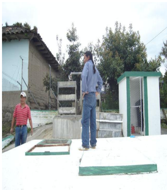
TANQUE DE ALMACENAMIENTO COMUNIDAD SAN OSE DE PUNGE
