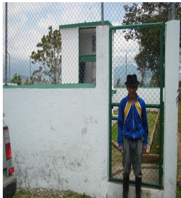
TANQUE DE ALMACENAMIENTO COMUNIDAD DE ALAMBUELA
