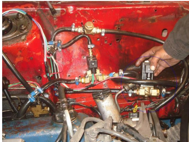
Fig. 80 Instalación de la válvula sin energía totalmente cerrada
