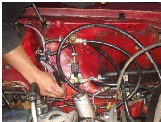
Fig. 79 Instalación de la válvula sin energía totalmente abierta
