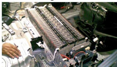
Batería de alta tensión Fuente Revista aficionados a la mecánica
