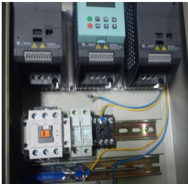
Figura 6.50. Montaje del tablero de control de los motores Fuente: Autores (Gabriela León, Germán Vaca)
