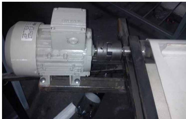
Figura 6.41. Montaje del motor para el Sistema de transporte. Fuente: Autor (Gabriela León)
