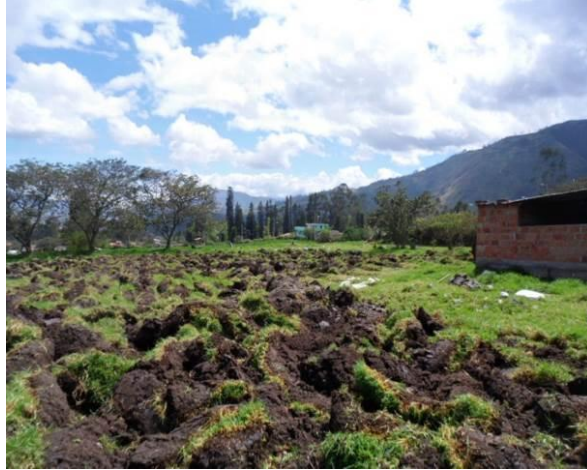
Fotografía 1. Preparación del terreno
