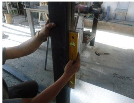
Figura N° 84. Nivelación del Soporte.
