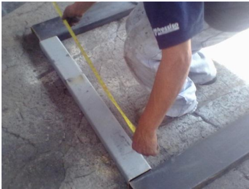
Figura N° 78. Medición de las Correas.
