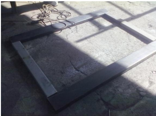
Figura N° 80. Armado de la Base.
