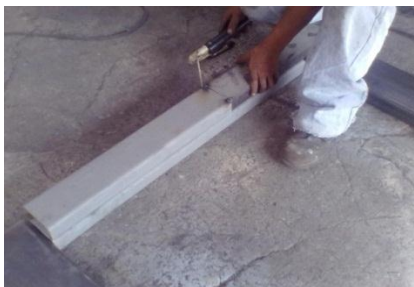
Figura N° 56. Suelda de las correas.
