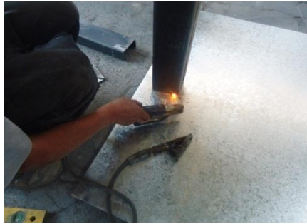
Figura N° 85. Suelda del Tubo a la Base.
