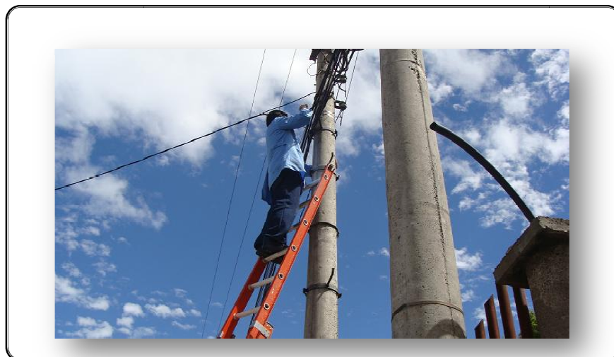
Ilustración 3:31 Colocación de Cableado en postes exteriores
