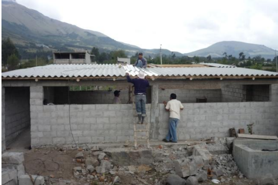
Fotografía N° 4 Construcción del galpón
