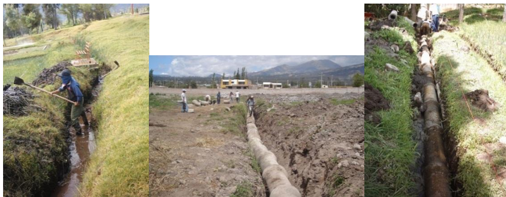
Imagen N° 16.- Trabajos en los drenajes
