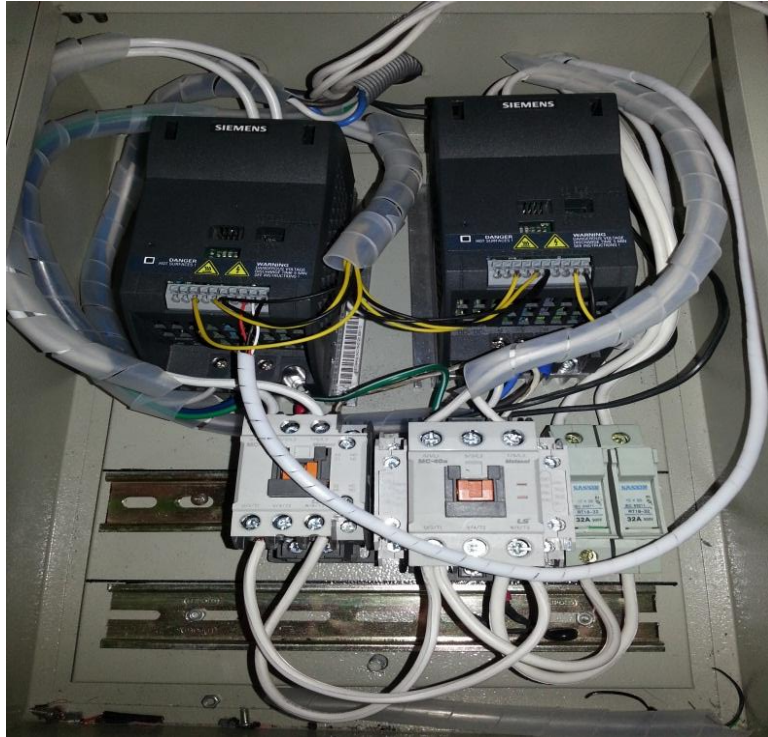
Figura 2.7 Montaje Tablero de Control Fuente: El Autor
