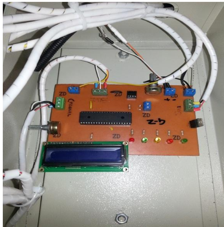
Figura 2.7 Montaje 2 Tablero de Control Fuente: El Autor
