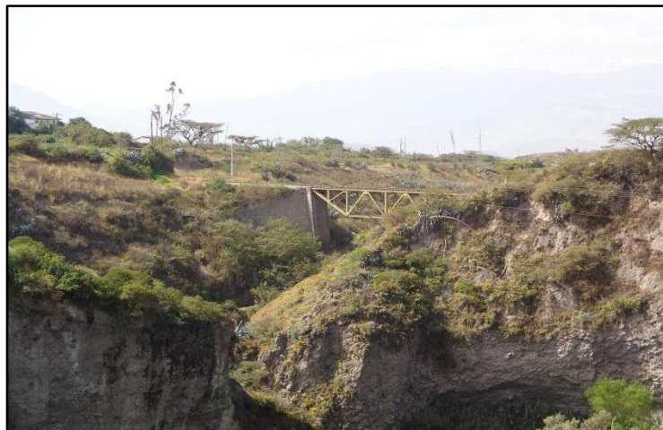
Fotografía 4: Vista panorámica del puente y cañón del Río Ambi. Fuente: Guzmán A, Herrera E. (2013)
