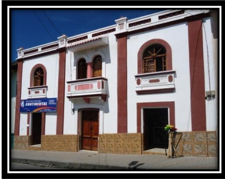
Ilustración 1 Edificación Patrimonial de la calle Bolívar Fuente: Archivo Municipal Elaborado por: Técnicos Patrimonio
