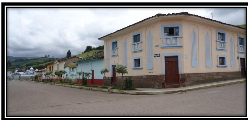
Ilustración 1: Casa Patrimonial, calle Ezequiel Landázuri
