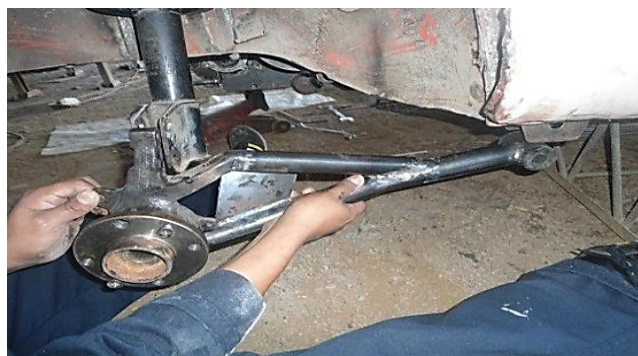
Figura 73. Colocación de las bases en el prototipo.
