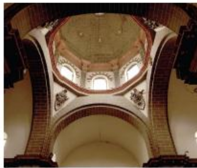
BOVEDA Principal de la Basílica de la Merced.
