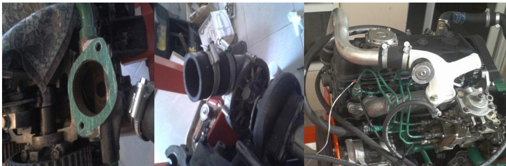
Figura 172. Instalación tubería de admisión.
