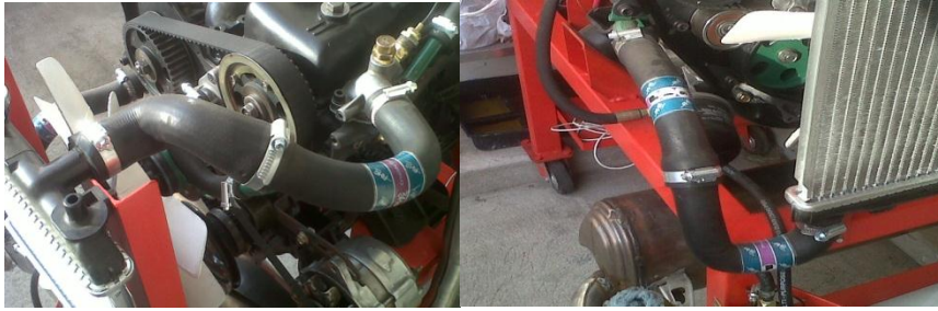
Figura 173. Mangueras de refrigeración instaladas.
