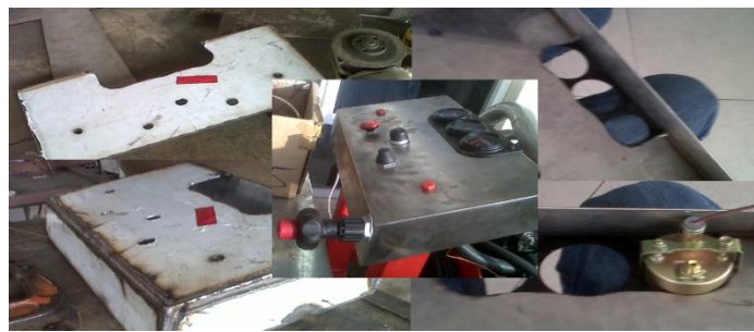
Figura 181. Fabricación y mecanizado del tablero de control.
