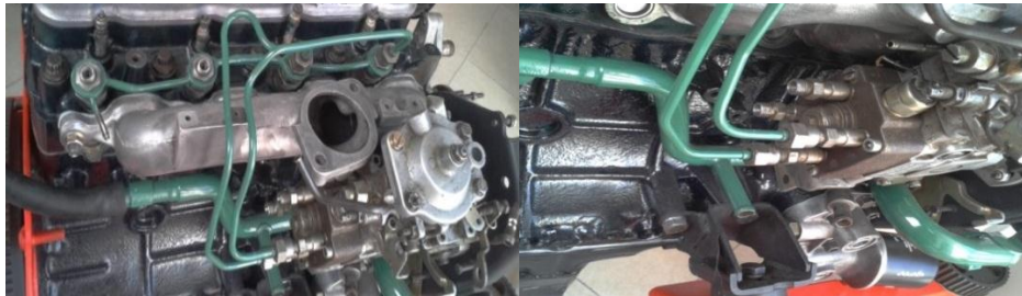
Figura 163. Instalación de tuberías y riel de retorno de combustible.
