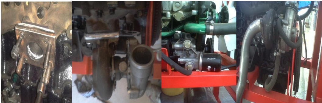
Figura 164. Instalación turbo compresor.
