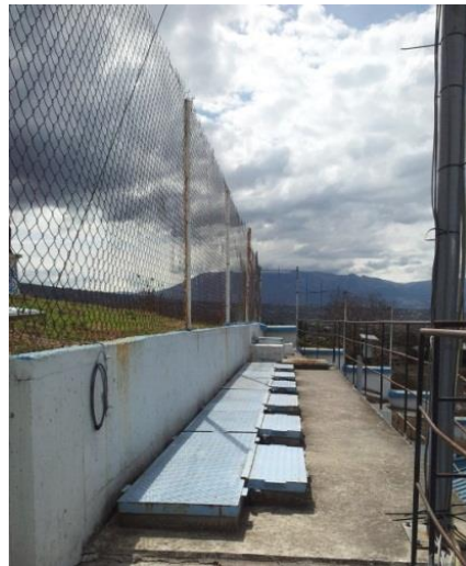
Fotografía 19.3: Captación de aguas de diferentes pozos (junio, 2012)
