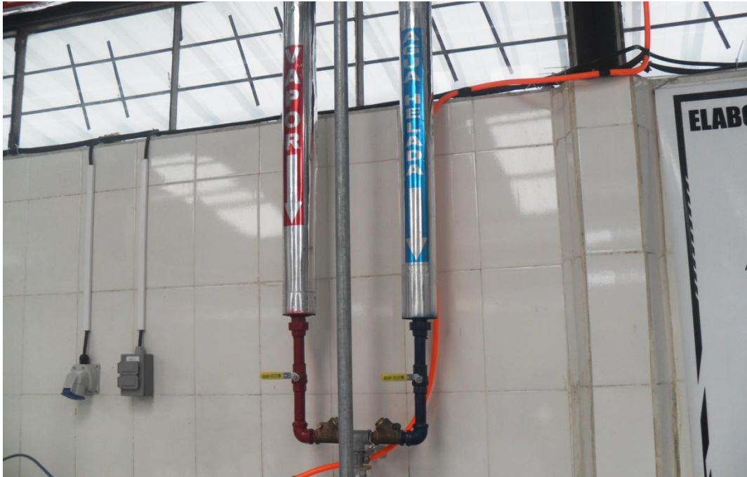
TUBERÍAS IDENTIFICADAS
