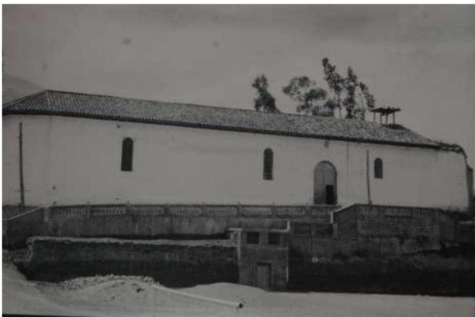
**Fotografía 15:** Construcción de adobe, con ventanas de madera y cubierta de teja.
