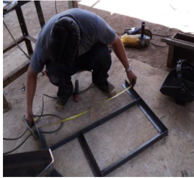
Fotografía 2.5 Proceso de armado de las partes de la estructura Fuente: Autor
