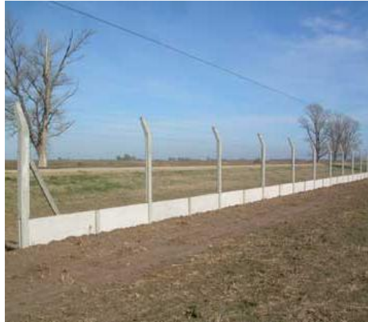
Fotografía 1.21 Cerco olímpico con zócalo de losa.
