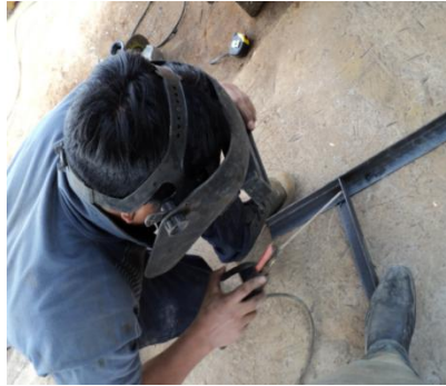
Fotografía 2.6 Proceso de soldadura eléctrica de las partes que componen la estructura Fuente: Autor
