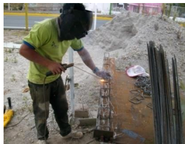
Fotografía 1.11 Elaboración de las columnas
