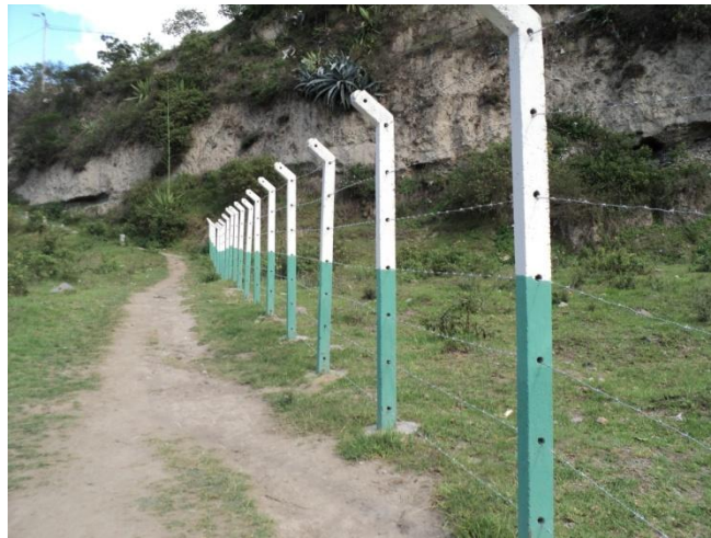
Fotografía 1.8 Cerca de un terreno con postes de hormigón armado para alambrado perimetral.
