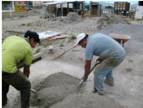
Fotografía 1.14 Mezclado manual de los materiales
