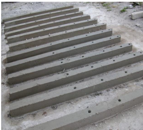
Fotografía 1.18 Curado de los postes
