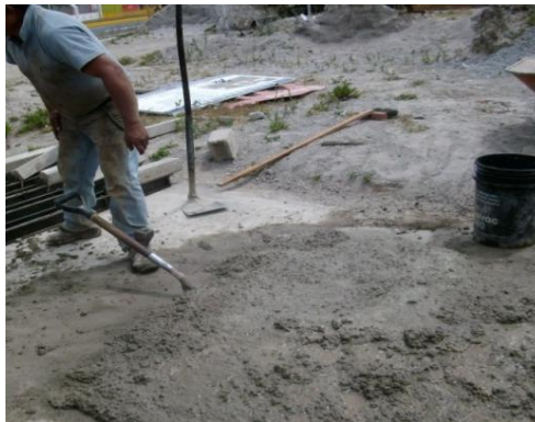
Fotografía 1.15 Hormigón preparado.
