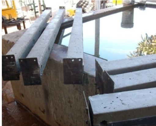
Fotografía 1.17 Fraguado de los postes
