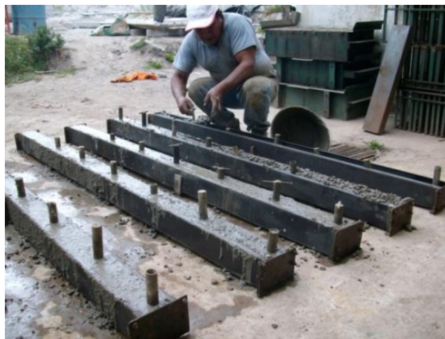
Fotografía 1.16 Moldeado de los postes.
