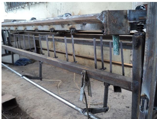
Fotografía 4.2 Construcción del sistema mecánico de evacuación del poste
