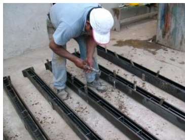
Fotografía 1.12 Armado de los moldes de acero
