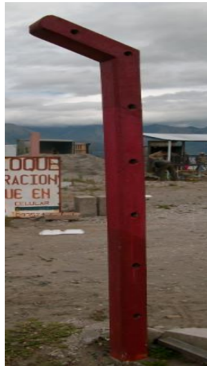
Fotografía 3.2 Postes con codo de hormigón armado para alambrado perimetral
