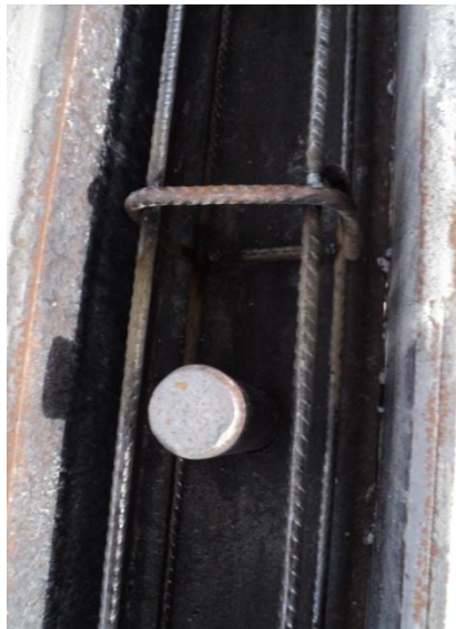
Fotografía 5.2 Colocación de la armadura en el interior del molde de la máquina
