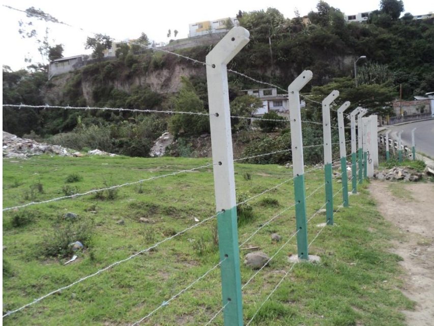
Fotografía 5.9 Alambrado perimetral con los postes fabricados en la máquina
