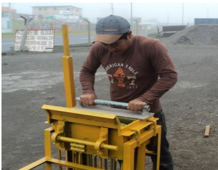
Fotografía 1.5 Sistema complementario de compresión del hormigón
