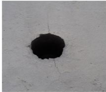
Fotografía 5.4 Poste después de realizarle la prueba de resistencia mecánica
