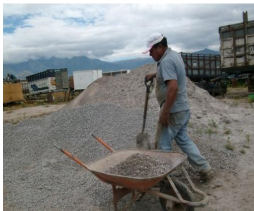
Fotografía 1.13 Dosificación de los materiales
