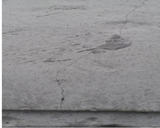
Fotografía 5.6 Poste después de realizarle la prueba de resistencia mecánica
