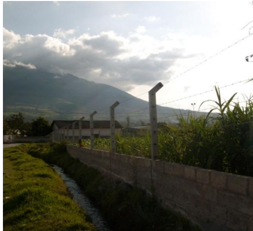
Fotografía 1.22 Cerco olímpico con zócalo de bloque hueco de hormigón.
