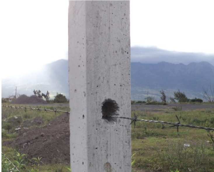
Fotografía 5.7 Orificio del poste fabricado en moldes de acero, después del paso del alambre de púas
