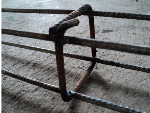
Fotografía 5.1 Construcción de la armadura
