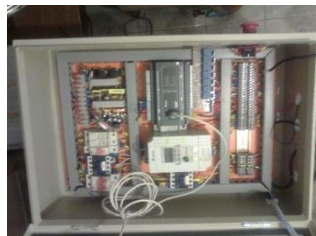
d) Tablero Terminado
