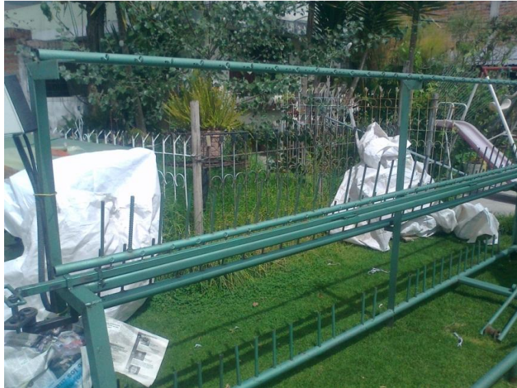
Figura 43. Pintura de la estructura de la máquina madejadora
