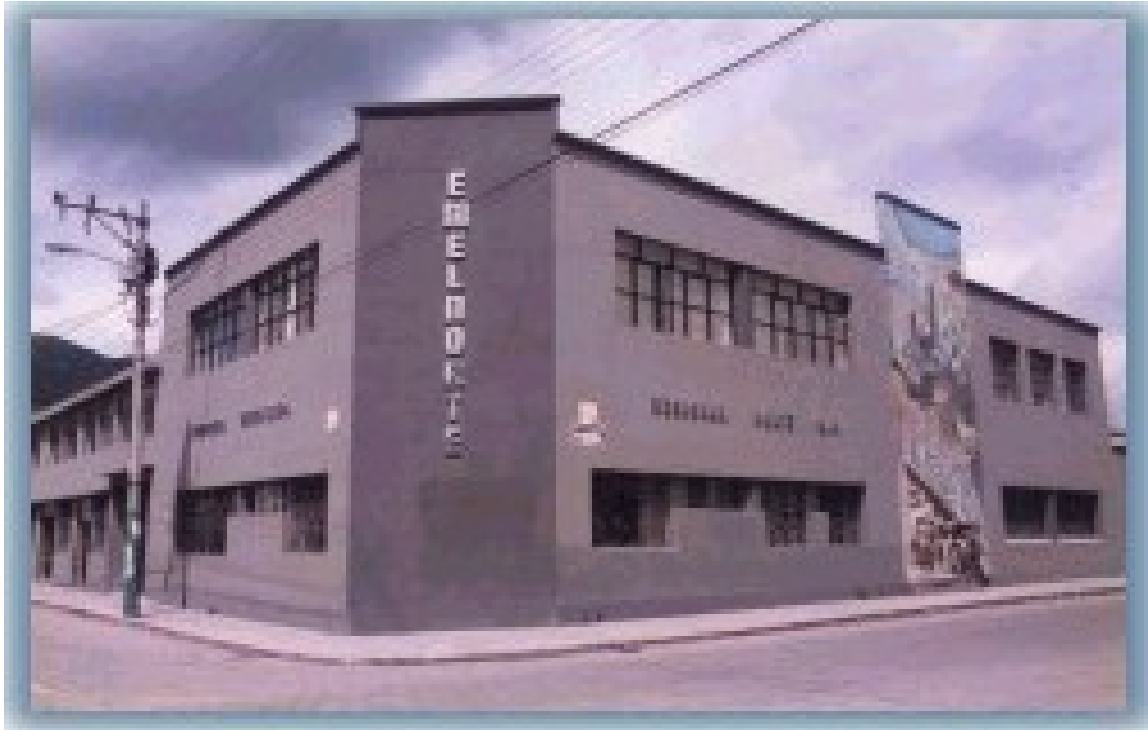
Gráfico N° 5. Instalaciones de EMELNORTE S.A.
