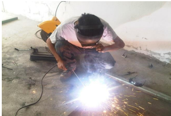
Figura 47. Cortado y soldado de la estructura
