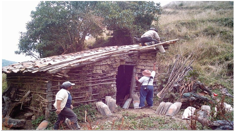
Colocación de Teja
