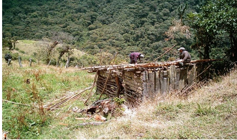
Colocación de chacla
