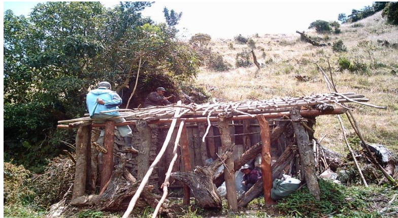
Estructuración del techo
