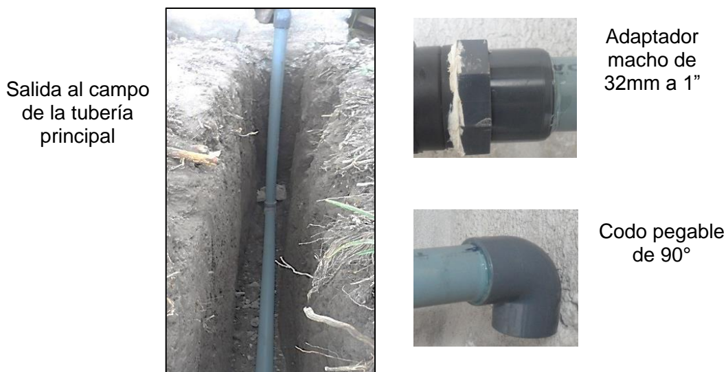
Figura 47: Instalación de tubería principal y sus accesorios
