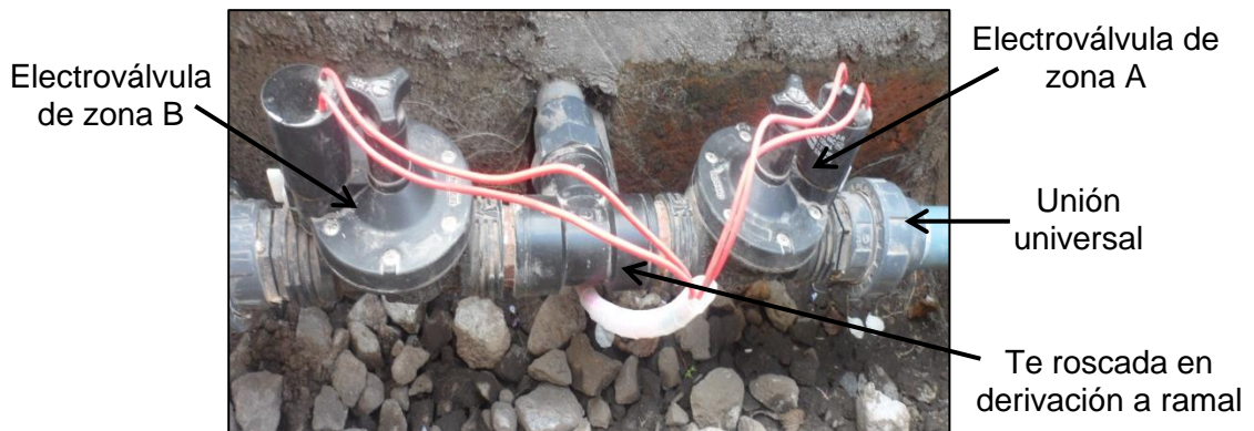
Figura 48: Instalación de electroválvulas para las ramas secundarias
