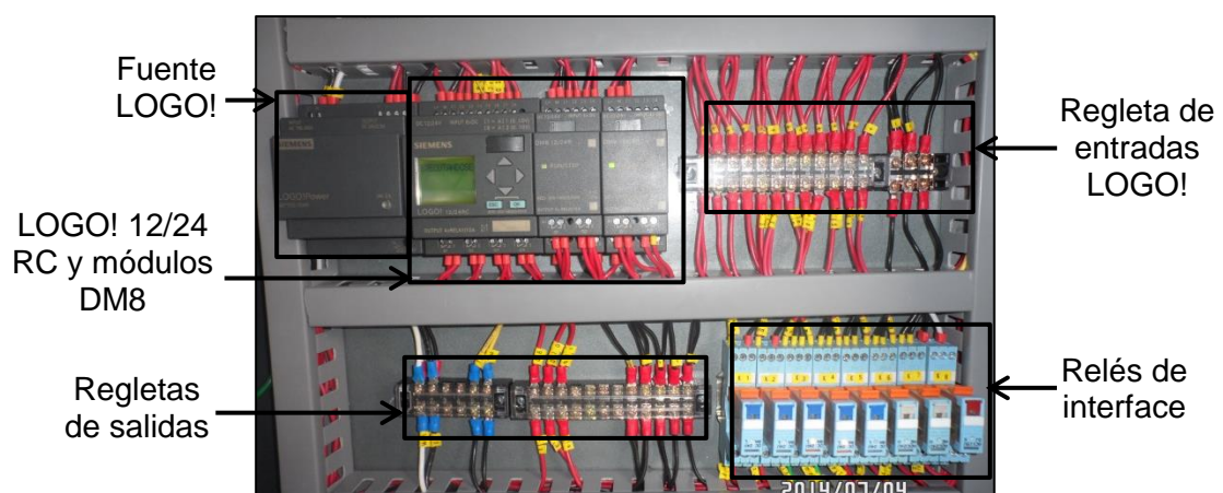
Figura 54: Instalación del circuito de control
