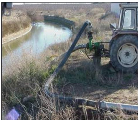
Figura 3: Sistema móvil de riego por aspersión (Sección toma de agua)
