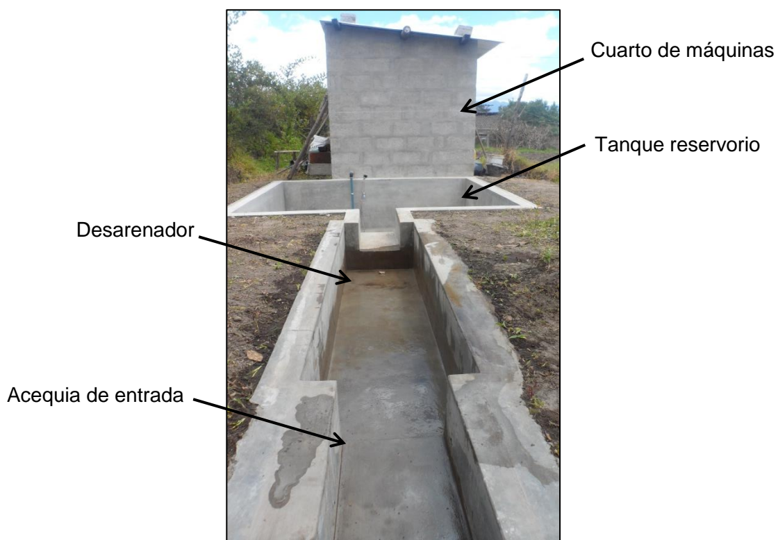
Figura 43: Ubicación de los componentes de obra civil
