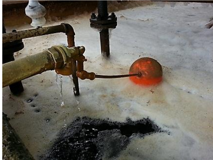
FIGURA10. Medición de agua en una piscina por flotador-boya de un sistema de refrigeración.
