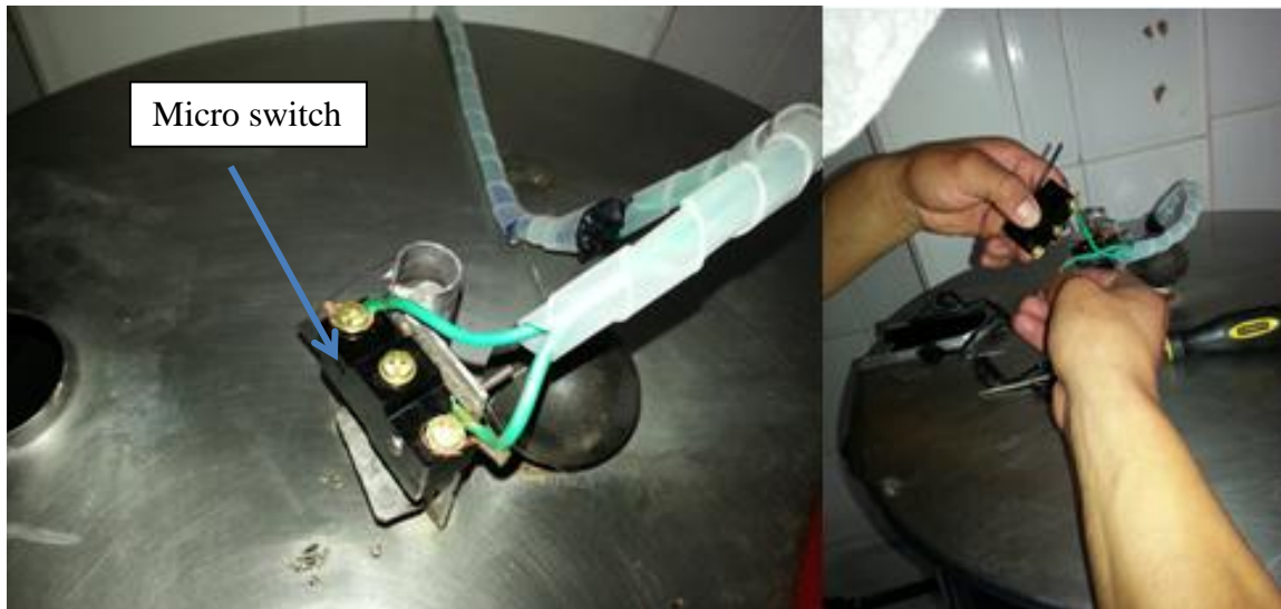
FIGURA 56. Montaje Micro Switch
