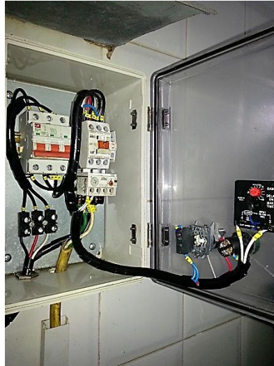
FIGURA 54. Montaje del Tablero de Control de Nivel
