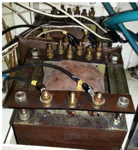
FIGURA 53. Montaje de los Transformadores
