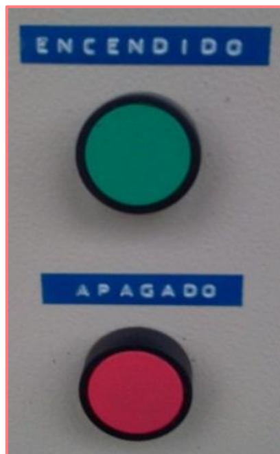
FIGURA 2.29 Pulsadores en el tablero de control
