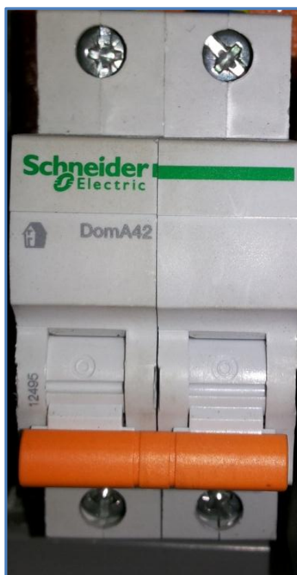
FIGURA 2.40 Breaker para la protección de la máquina
