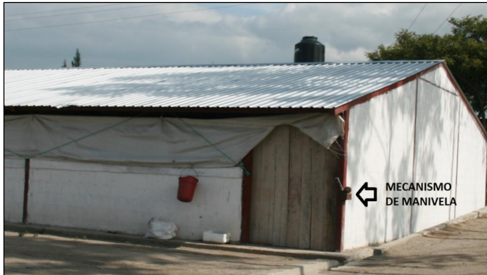
Figura 11.- Mecanismo de Apertura Cortinas Externas
