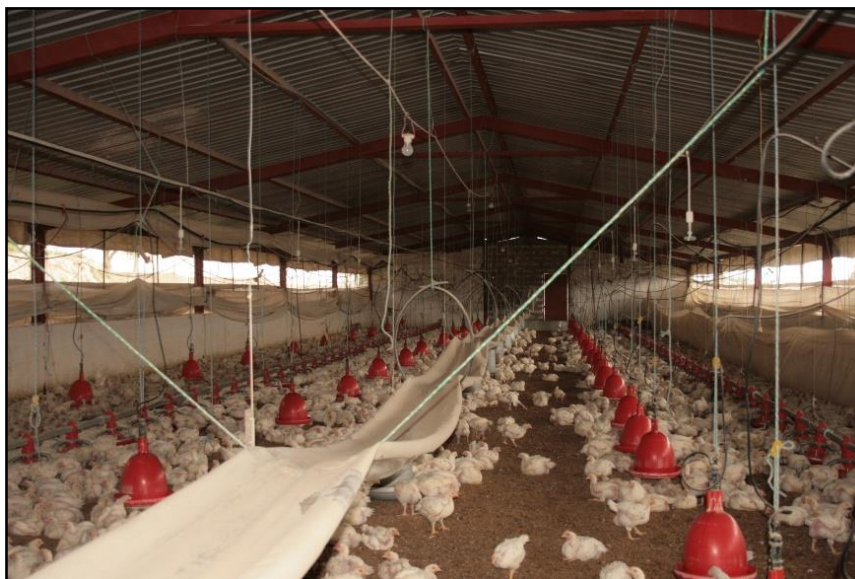
Figura 6.-Estructura del Galpón
