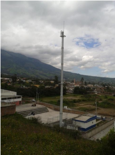
Figura 5: Torre estructural de la CNT. Fuente: Parroquia de Caranqui.
