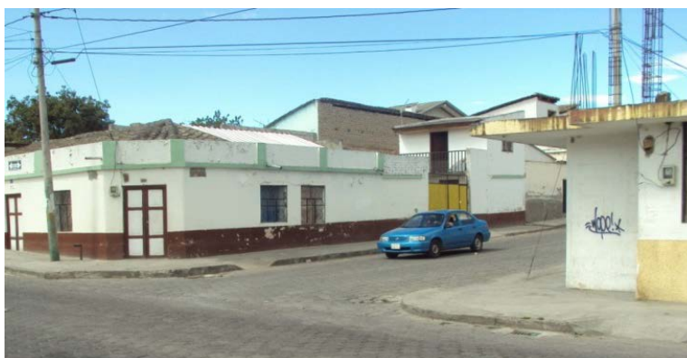
Figura 7. Vista de la calle Guaranda y San Salvador
