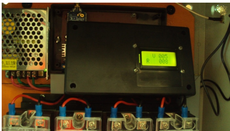
Figura 74. Montaje de las placas y demás elementos en el gabinete metálico
