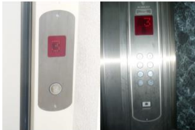
Figura 4. Botones de llamada de cabina y de las puertas de hall
