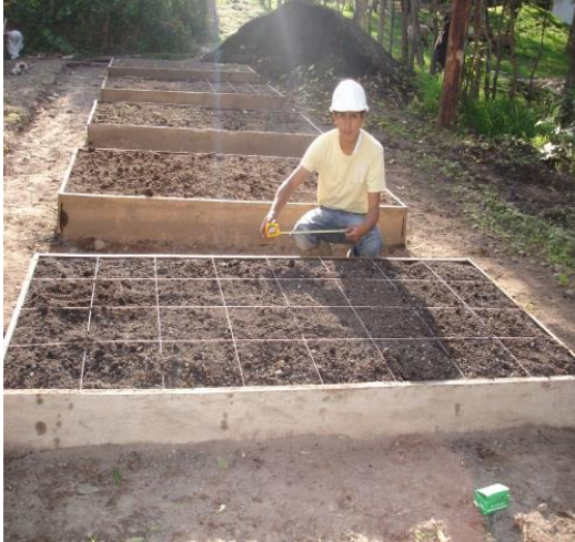
Construcción de cajas 1.20m x 1.20m (Unidad Experimental)
