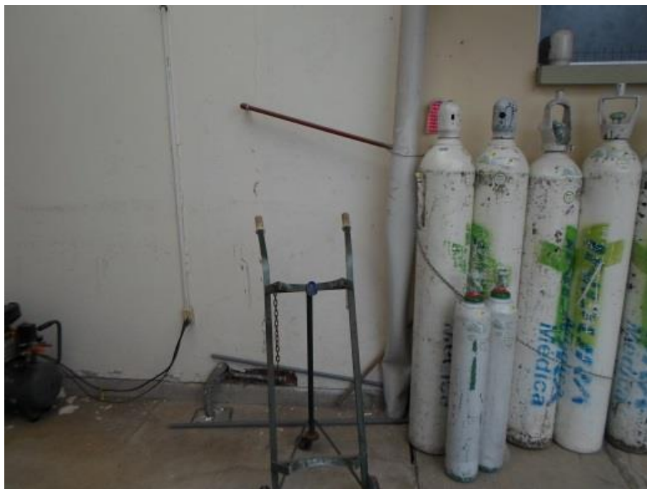
FACTORES DE RIESGOS ELÉCTRICOS
