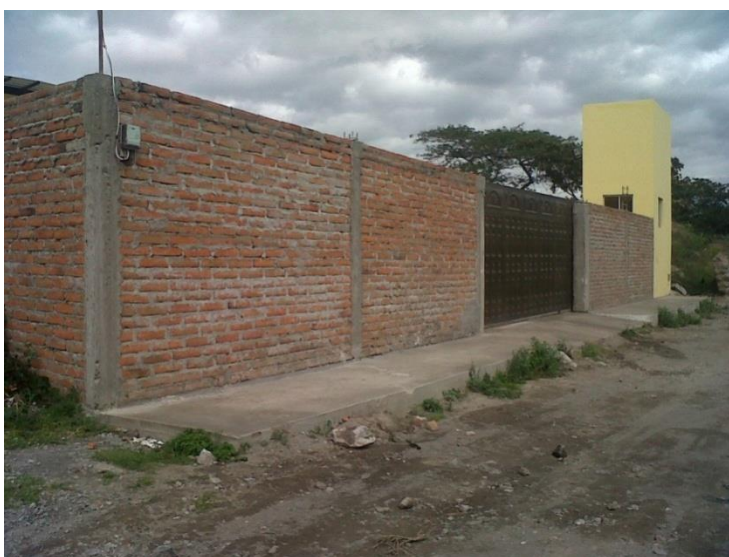
Figura 31. Entrada terreno COPCOLES
